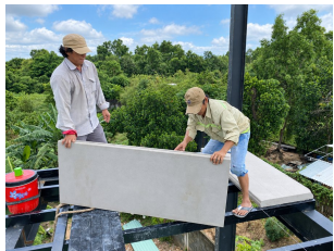
Tấm ALC gác lên hệ dầm thép làm sàn nhẹ — việc gạch AAC không làm được.
