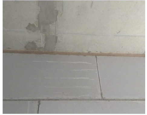
Khe đỉnh tường sát đáy dầm đã trám kín, liên tục suốt chiều dài tường – ảnh công trường, trước khi dán lưới và tô.
