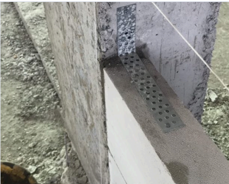
Pát thép gấp hai cánh: một cánh áp vào cột và liên kết với cột bằng vít, cánh kia nằm trên mặt gạch – chụp lúc vừa lắp, trước khi phủ vữa và xây hàng tiếp theo.
