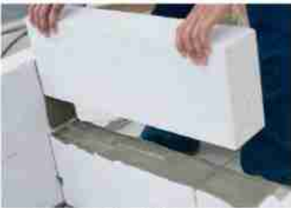
Lớp vữa xây được rải bằng bay răng cưa
