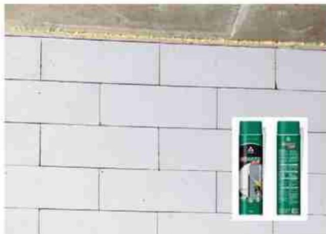
Thi công khe hở đầu tường bằng foam PU hoặc vật liệu mềm tương đương.
