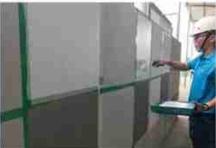
Thi công sơn nước trực tiếp trên bề mặt vữa Skimcoat EBS-300 (không cần bả Matit)
