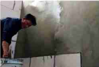
Thi công vữa tô Skimcoat EBS-302
