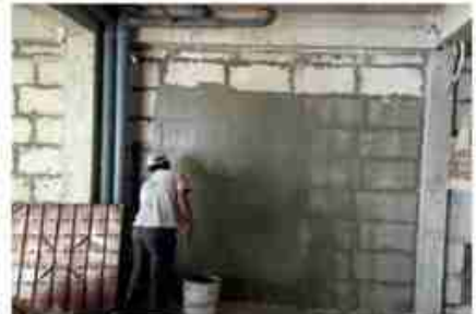
Thi công tô vữa xi măng cát thông thường trên lớp vữa lót Primer EBH-401
