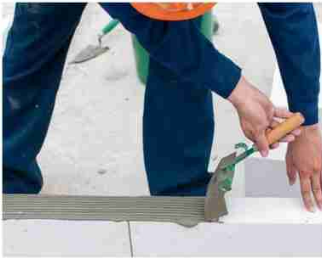
Sử dụng bay răng cưa giúp mạch vữa đều, bám dính tốt và tiết kiệm vật tư.
