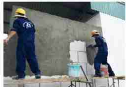
Thi công vữa tô chuyên dụng EBP-202
