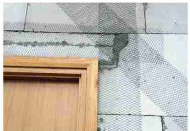
Thi công dán lưới tại các vị trí cửa, lỗ mở và rãnh M&E, vị trí tiếp giáp với các loại vật liệu khác.
