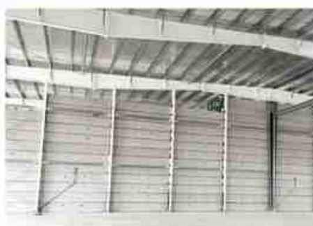
Nhà xưởng BW Bình Dương
