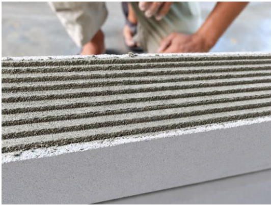
Vữa kéo bằng bay răng cưa đúng khổ. Chiều cao sóng vữa quyết định lượng vữa hao — đây là chỗ chênh lệch định mức bắt nguồn.
